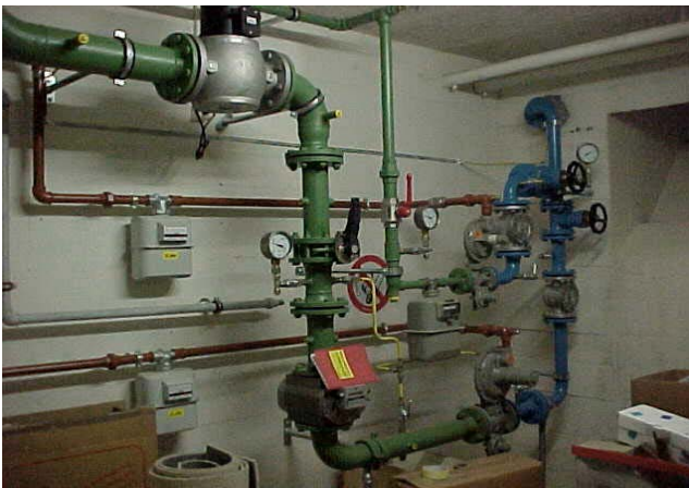
Gas - Druckreduzierstation
