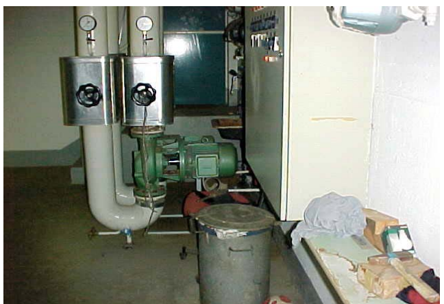
Fernleitungspumpen
