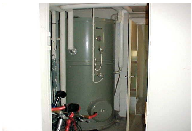
Unterstation Wassererwärmung
